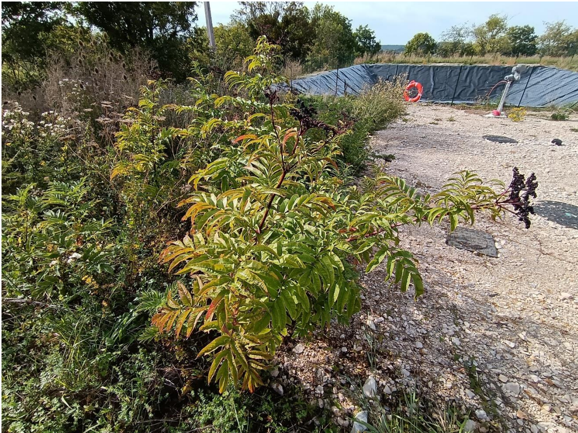
Zone de mise en compatibilité au Nord-Ouest : bassin d'eau pluviale
