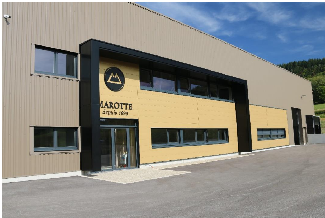
Vue de la nouvelle extension de l'entreprise, photographie prise le 27/09/2023
